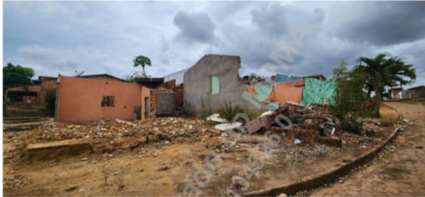
Imagem 2. Residências abandonadas na Rua Dr. Medeiros, Centro, Buriticupu/MA, em 06/12/2024.
